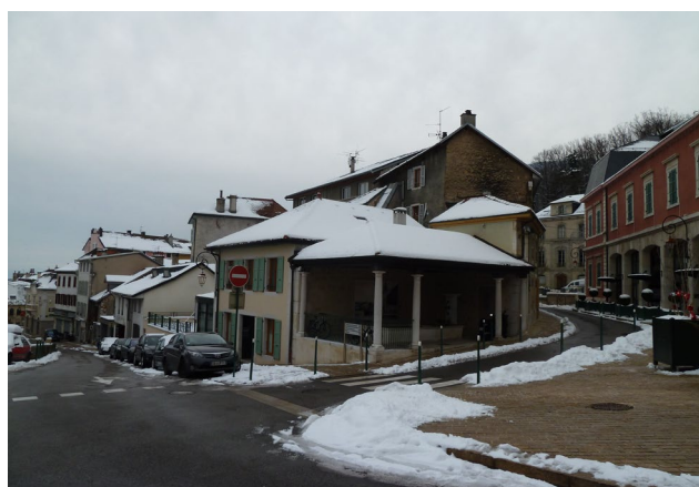
4. Localisation du lavoir au carrefour ; tous les éléments bâtis de chacune des rues participent à la bonne présentation du lavoir
